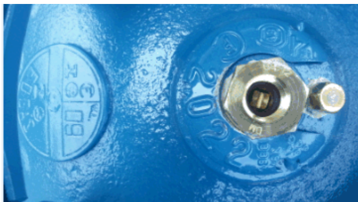
FIGURA 6 – PLACAS DE IDENTIFICAÇÃO DA REQUALIFICAÇÃO
